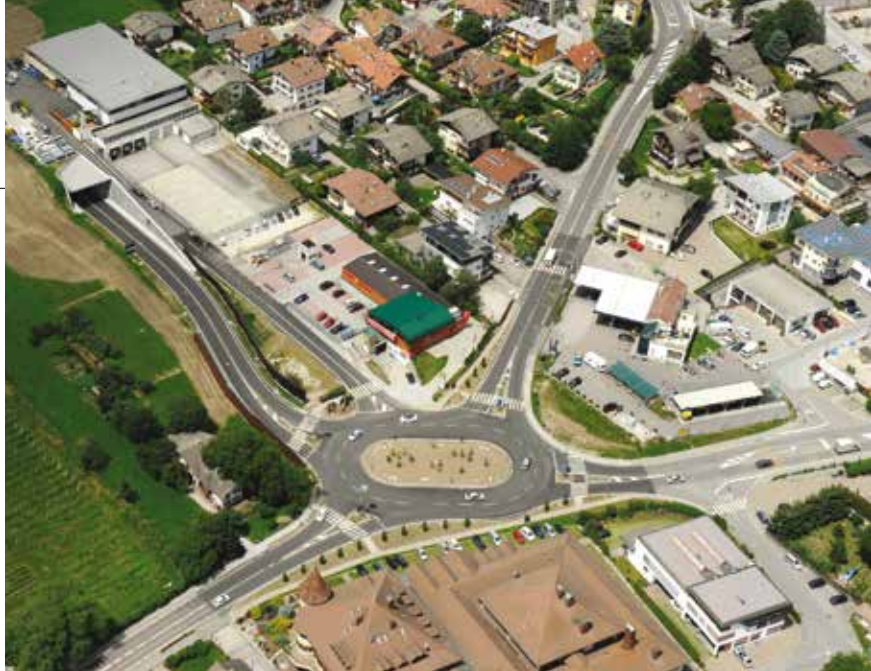
12. Vista aerea della rotatoria di collegamento tra la S.S. 12 e la S.S. 49
