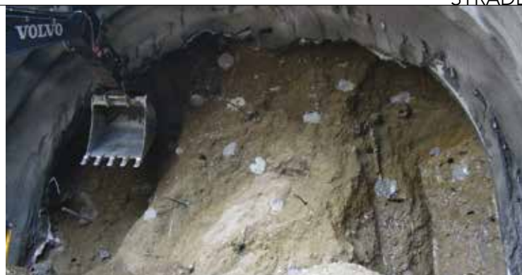
6A e 6B. Lo scavo in roccia: filladi di Bressanone (6A) e in terreno sciolto (6B); si osservano le colonne di jet-grouting nel nucleo dopo le recenti alluvioni
