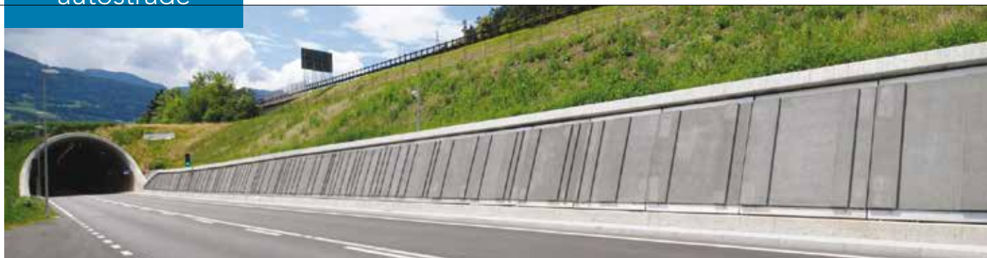
20. I pannelli in porebeton presso il portale Nord della galleria Nord
