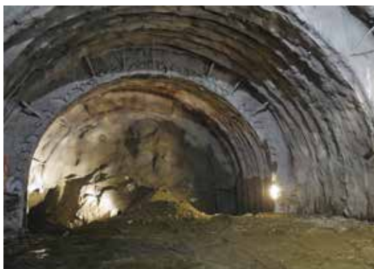
13A e 13B. (13A) Fronte di scavo galleria svincolo centrale e (13B) Realizzazione arco rovescio
