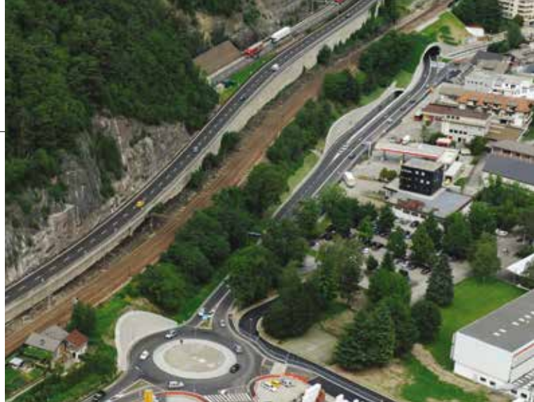
2. Veduta dello svincolo Sud e dell'imbocco Sud della galleria Sud
