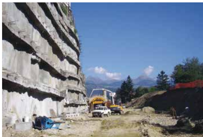
11. Le pareti chiodate tirantate della galleria Nord
