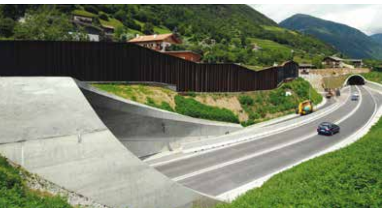
19. Le barriere acustiche presso il portale Nord della galleria Sud
