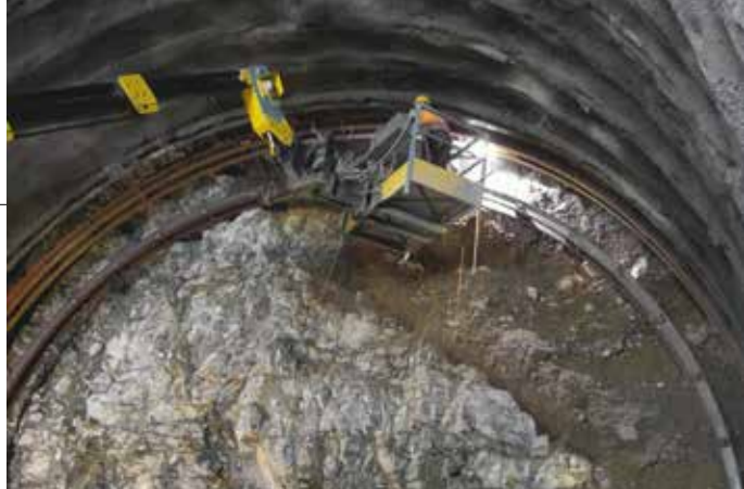
9. La posa della prima centina presso il quinto campo dall'imbocco Sud della galleria Sud (attraversamento FF.SS.)
