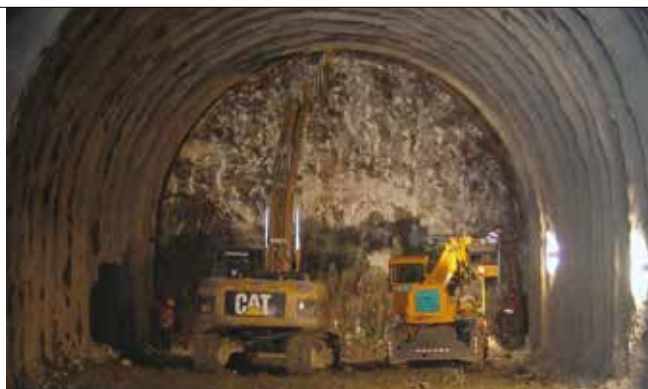
6A e 6B. Lo scavo in roccia: filladi di Bressanone (6A) e in terreno sciolto (6B); si osservano le colonne di jet-grouting nel nucleo dopo le recenti alluvioni
