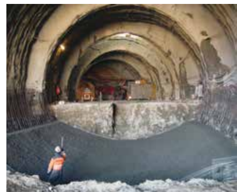
13A e 13B. (13A) Fronte di scavo galleria svincolo centrale e (13B) Realizzazione arco rovescio
