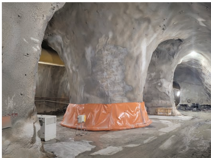
5. La rotatoria in caverna: il pilastro centrale nelle prime fasi di impermeabilizzazione e, a monte e a valle, i due pilastri provvisori che saranno demoliti a cerchiaggio completato del pilastro centrale
