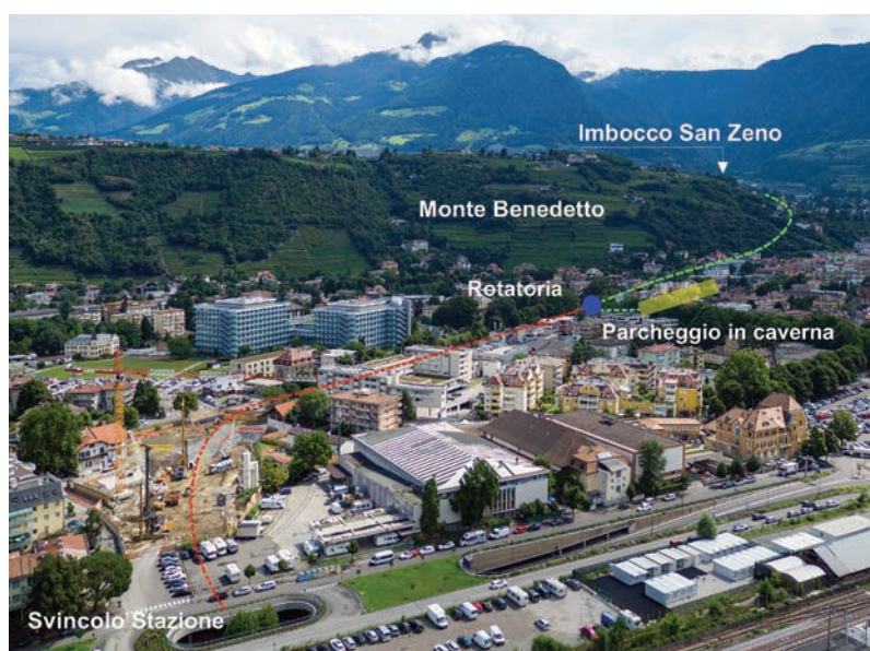
1. Il posizionamento schematico della galleria Küchelberg secondo lotto rispetto alla città di Merano: la linea di colore rosso evidenzia lo scavo in materiale sciolto; quella in colore verde, lo scavo in roccia
