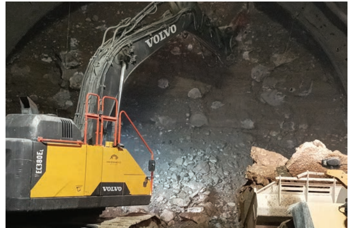
9. Lo scavo del fronte consolidato
