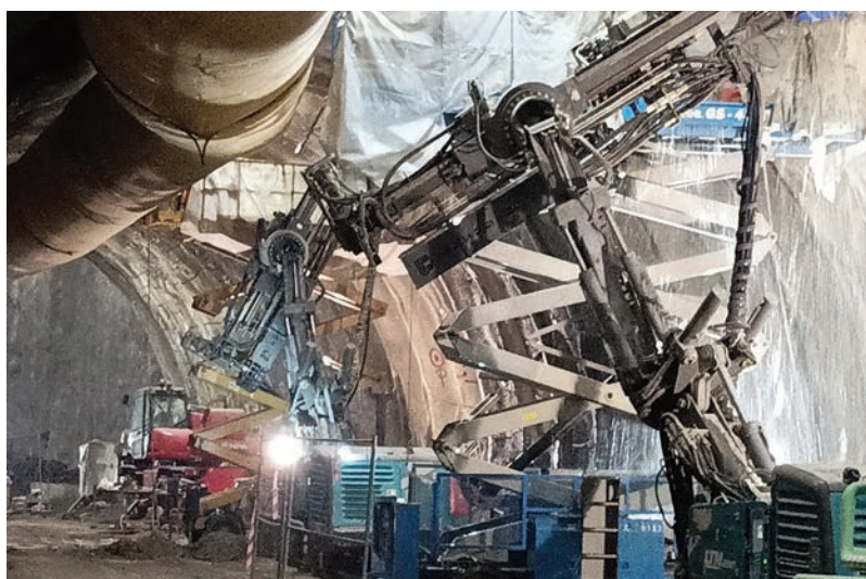
18. Le perforazioni per le iniezioni
