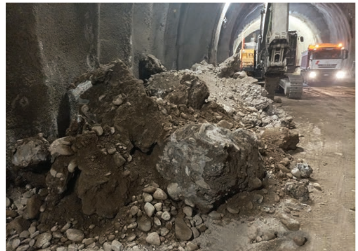
10. Il corpo delle colonne jet presenti nello scavo
